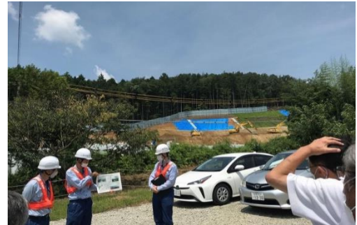
(写真は瀬戸非常口トンネル工事ヤード)
