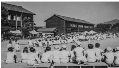
木造校舎の西小学校
