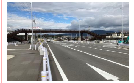
西小学校入口の歩道橋 (右→駒場線)
