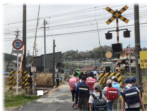
工事前のJR尾崎踏切（下校風景）
