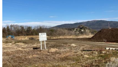
現在も閉鎖整備が続く旧最終処分場
