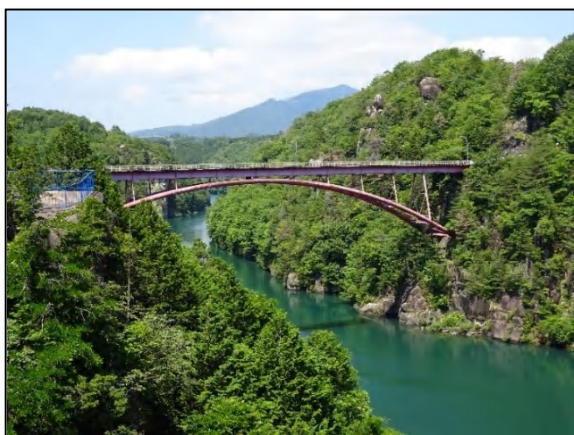
「源済橋」は橋長 144m、幅員 4.5m、竣工式は昭和45年6月1日 事業費 115,179,000 円
