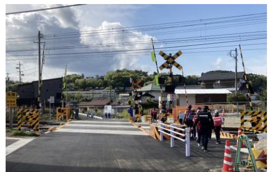
改良後（一部工事中）
